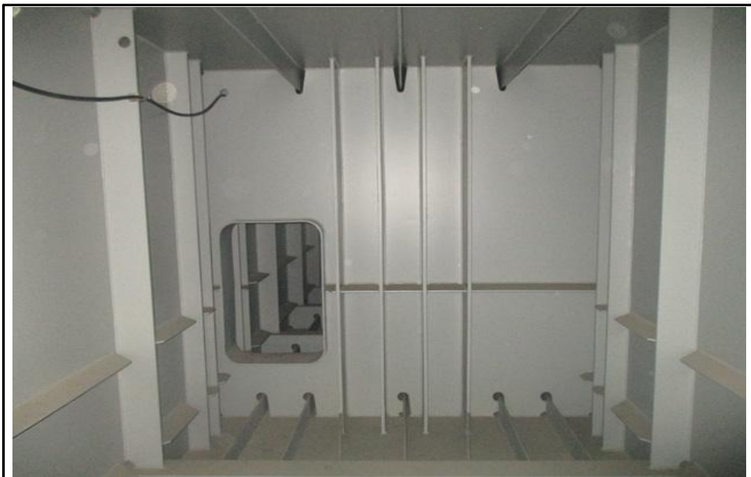
강박스 내부 전경
